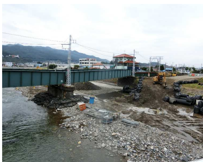
資器材搬入路作成中
