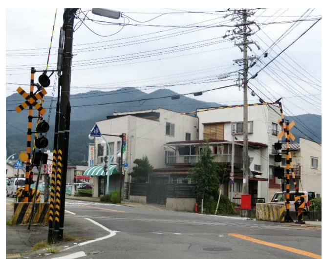
「閉まらずの踏切」警報機左横2mが被災現場
