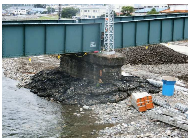
ジャッキ上げまでの土嚢固め
