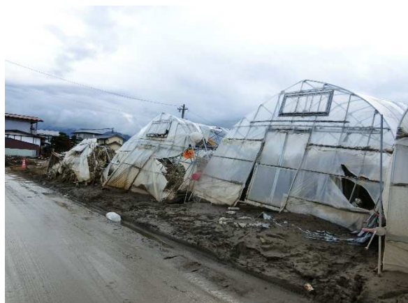
倒壊したビニールハウス
