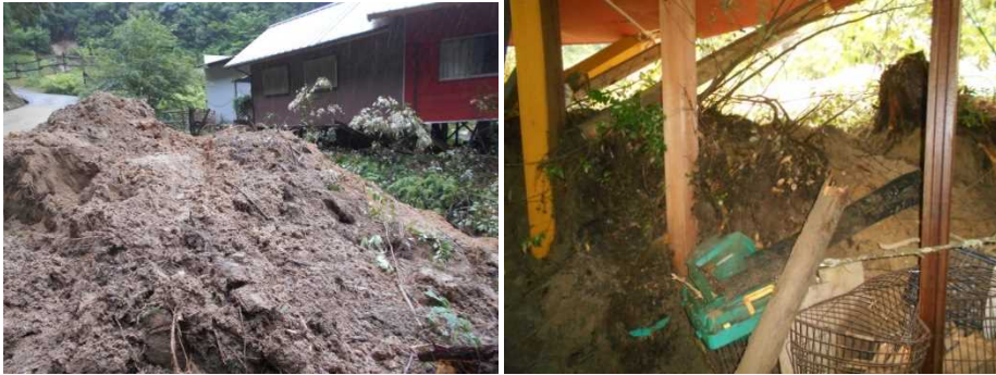
▲土砂が敷地内に流れ込み家屋の柱をなぎ倒した
