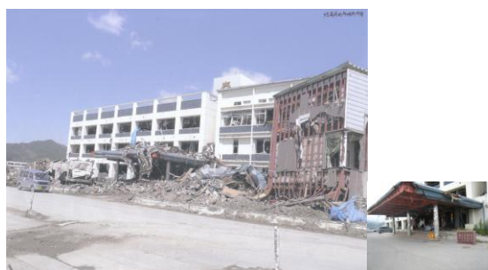
陸前高田市役所庁舎(左:被災直後,右:H24・8玄関部)
