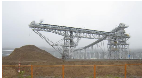
ベルトコンベアシステムによる土地造成
