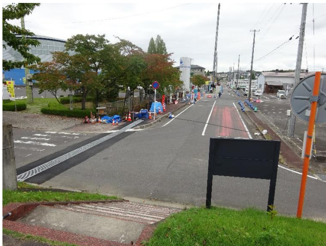
大雨時の道路冠水箇所の確認
