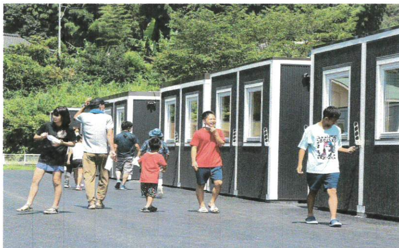
1、多目的仮設住宅
