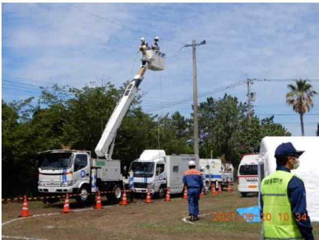
九州電力による電線応急復旧等訓練
