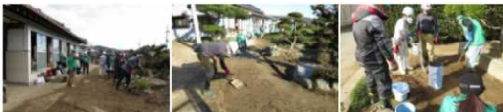
土砂の除去作業を行い、整地しながら少しずつ元通りに。
