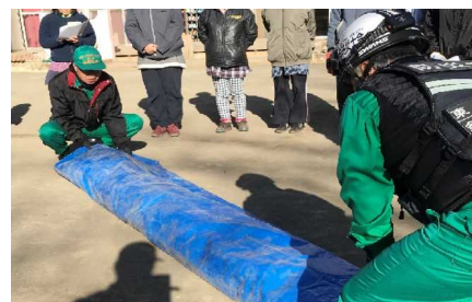
【ブルーシートで堤づくり】
