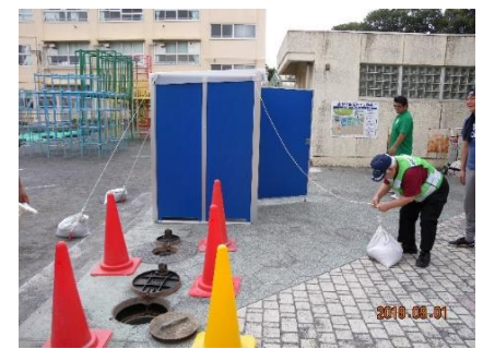
吹き飛ばされないようロープで展張
