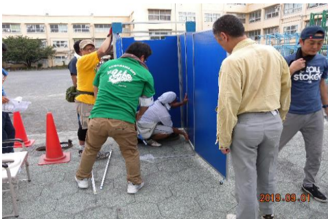
仮設トイレの組み立て作業中
