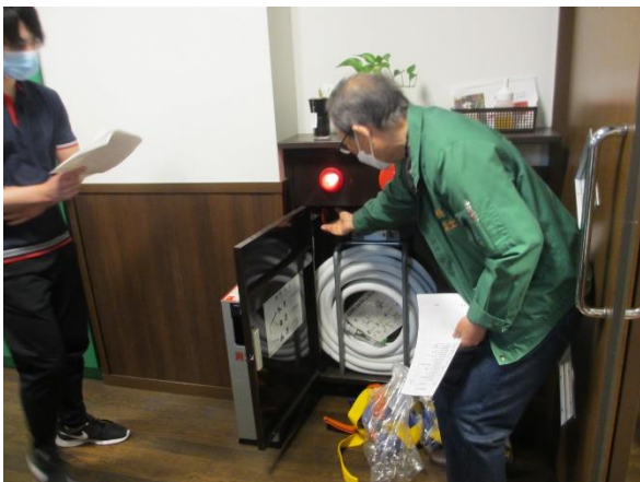
消防用設備の確認と使用訓練
