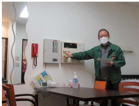
消防用設備の確認と使用訓練
