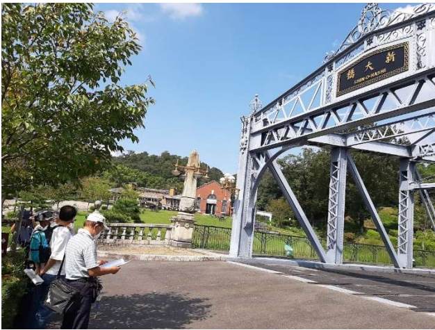
↑ 隅田川新大橋（お助け橋）
